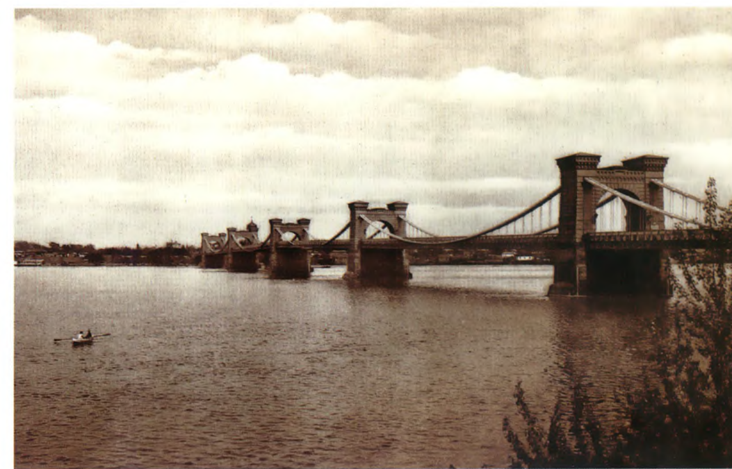
Ил. 6. Николаевский цепной мост. 1911 г.
